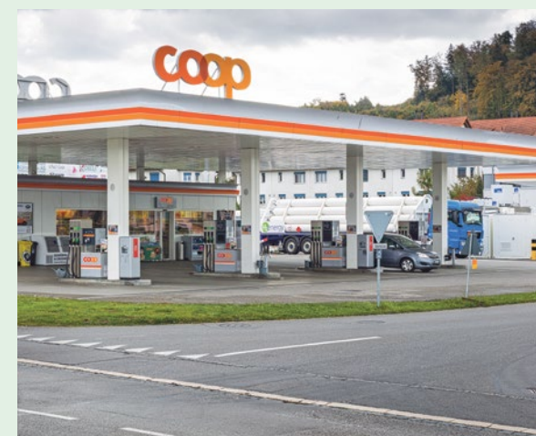
Was die Linke und Grünen gerne ausblenden: Die Suche nach Alternativen hat schon längst begonnen, eingeleitet von innovativen KMU – ohne Vorschriften und Bevormundung! Beispiel: «Wasserstoff-Tankstellen».
