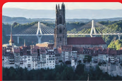
Pont de la Poya
