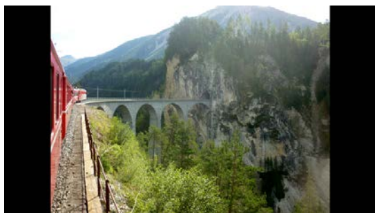
Bild 3: Viadukt der Rhätischen Bahn
